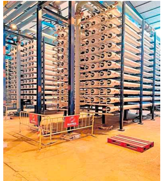
Desaladora de Marbella, con sus nuevos bastidores y filtros. SUR
