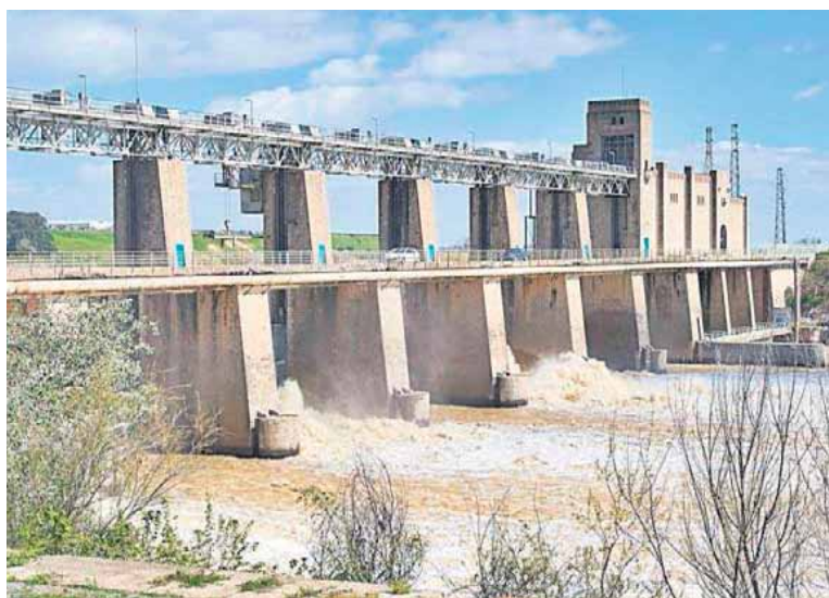
La captación de agua se hará aguas arriba de la presa de Alcalá del Río, en la imagen.
